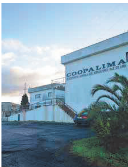
3. EDIFÍCIO DA COOPERATIVA
