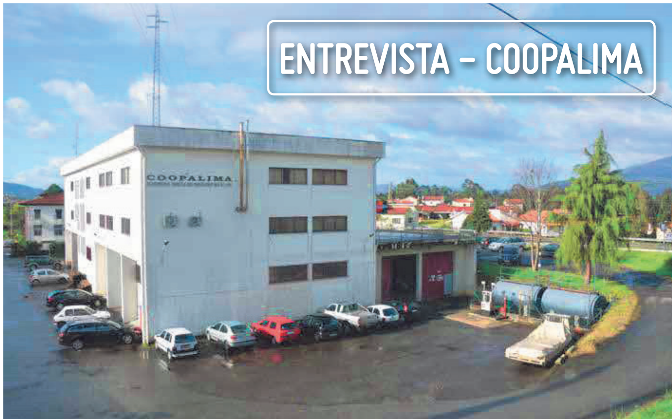
1. EDIFÍCIO DA COOPERATIVA
