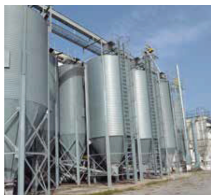
6. SILOS DE ARMAZENAMENTO DE MATÉRIAS-PRIMAS PARA FABRICO DE ALIMENTAÇÃO ANIMAL
