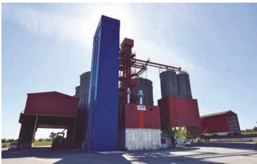
3. UNIDADE DE SECAGEM E ARMAZENAMENTO DE CEREIS EM BEJA
