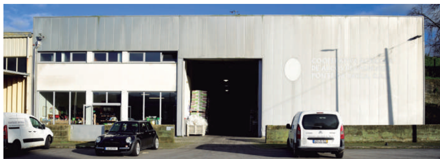
3. INSTALAÇÕES DA COOPERATIVA NA ZONA INDUSTRIAL
